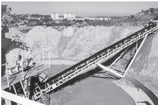
Estação de Reciclagem Pampulha SLU/PBH
