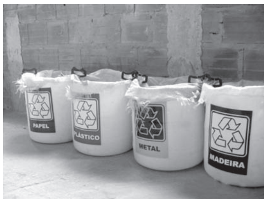
Coleta Seletiva em um canteiro de obras
