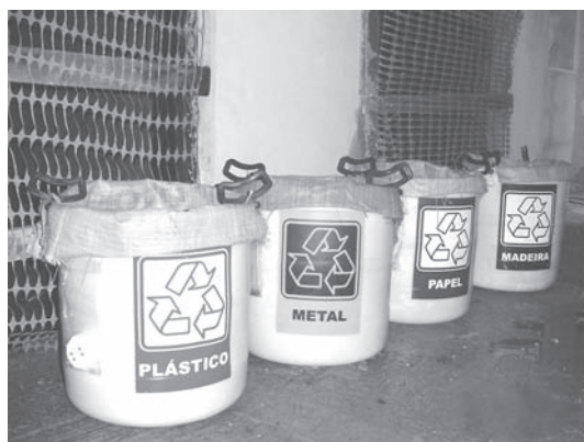
Coleta Seletiva em um canteiro de obras
